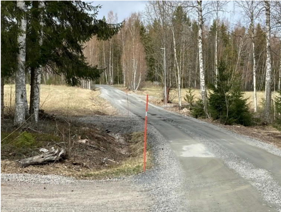
Figur 18. Korsningspunkt vid Näset där nytt område är tänkt att ansluta, här finns belysning uppsatt. Foto: WSP
