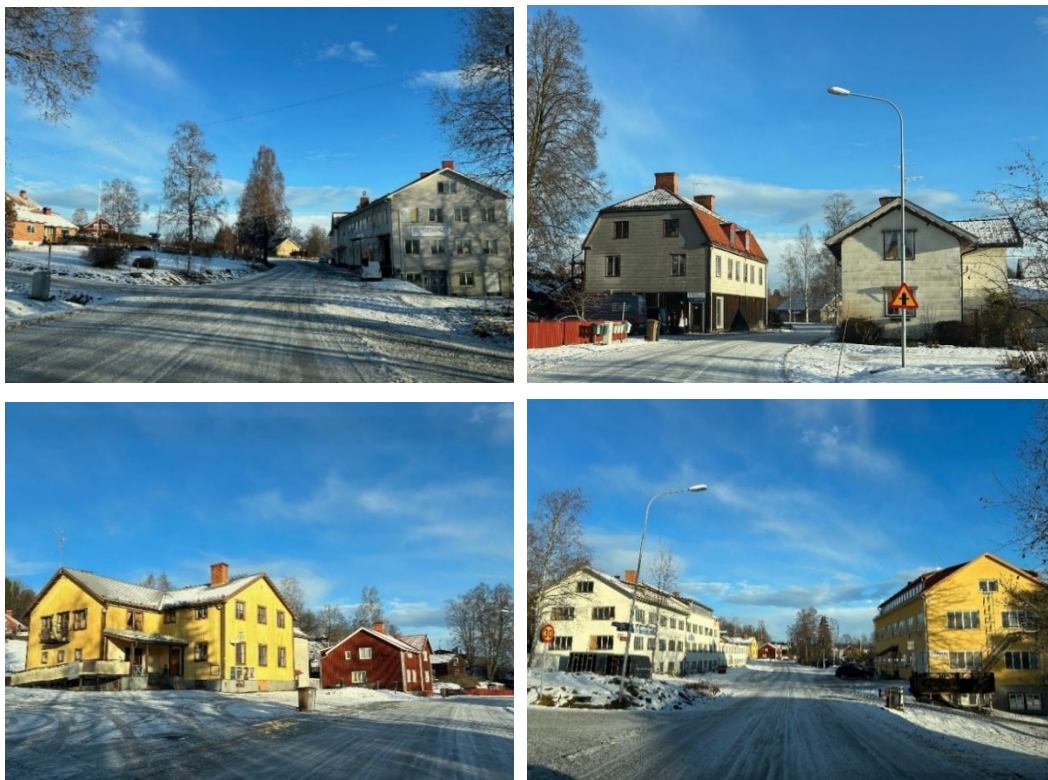
Figur 19. Fotografierna visar exempel på byggnadskarakterer kring Skovägen, från korsningen Bävervägen fram till Finnbacken.
