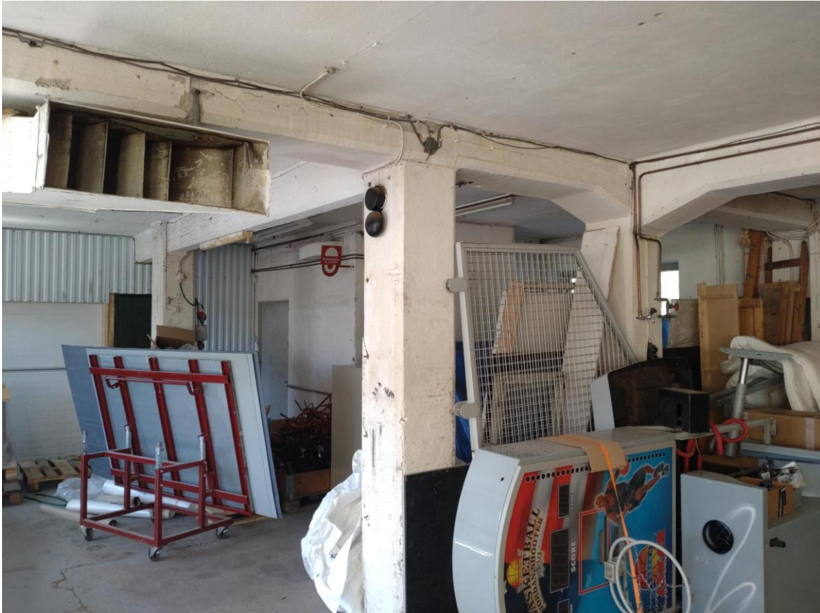
Befintlig betongkonstruktion plan 1.
