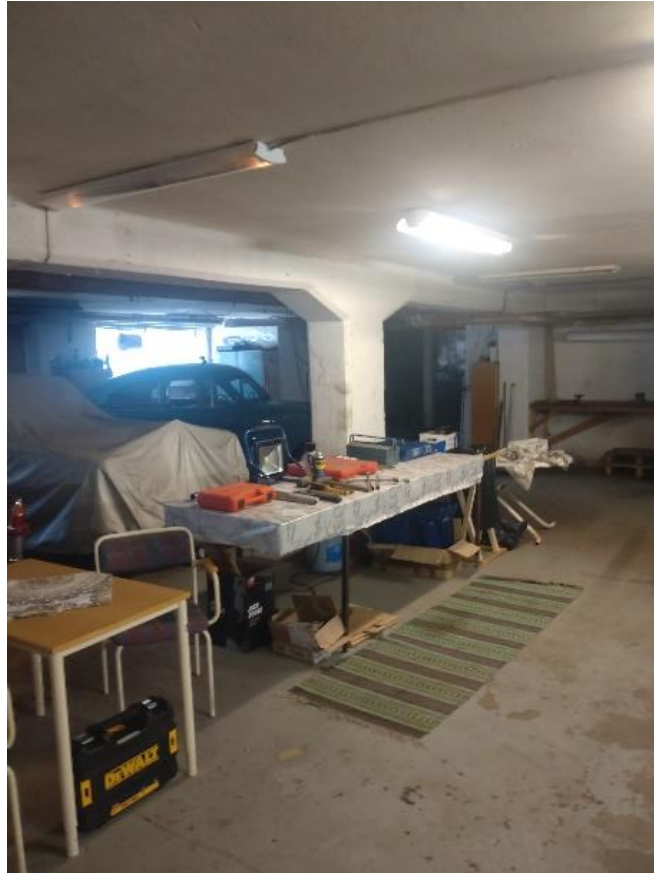
Befintlig betong konstruktion bottenplan.
