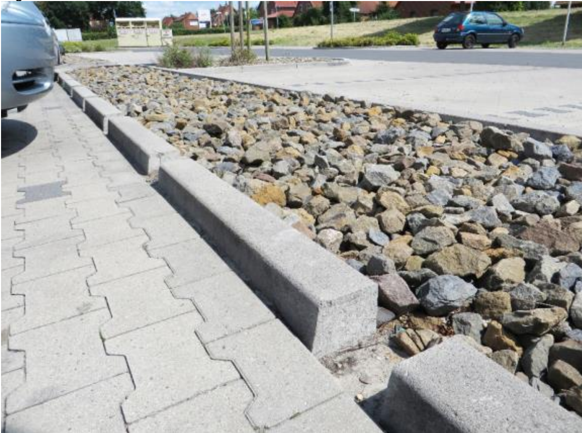
Figur 9. Exempel makadammagasin, källa: Svenskt Vatten rapport nr 2019-20.
