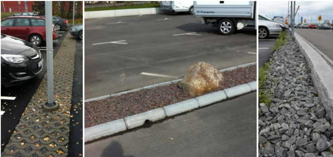
Figur 8. Exempel på utformning av makadammagasin.
