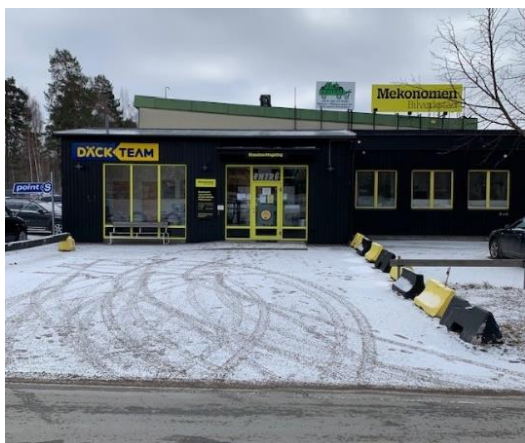
bild Byggnaden som används av Mekonomen.
