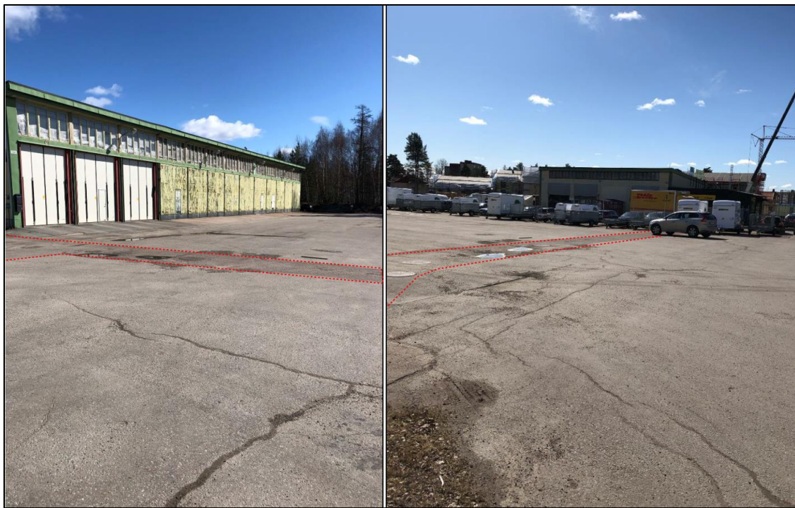
Figur 10. Avloppsledning och brunnar (objekt 10) som återfinns i västra delen av området 3, markeras med streckad röd linje.
