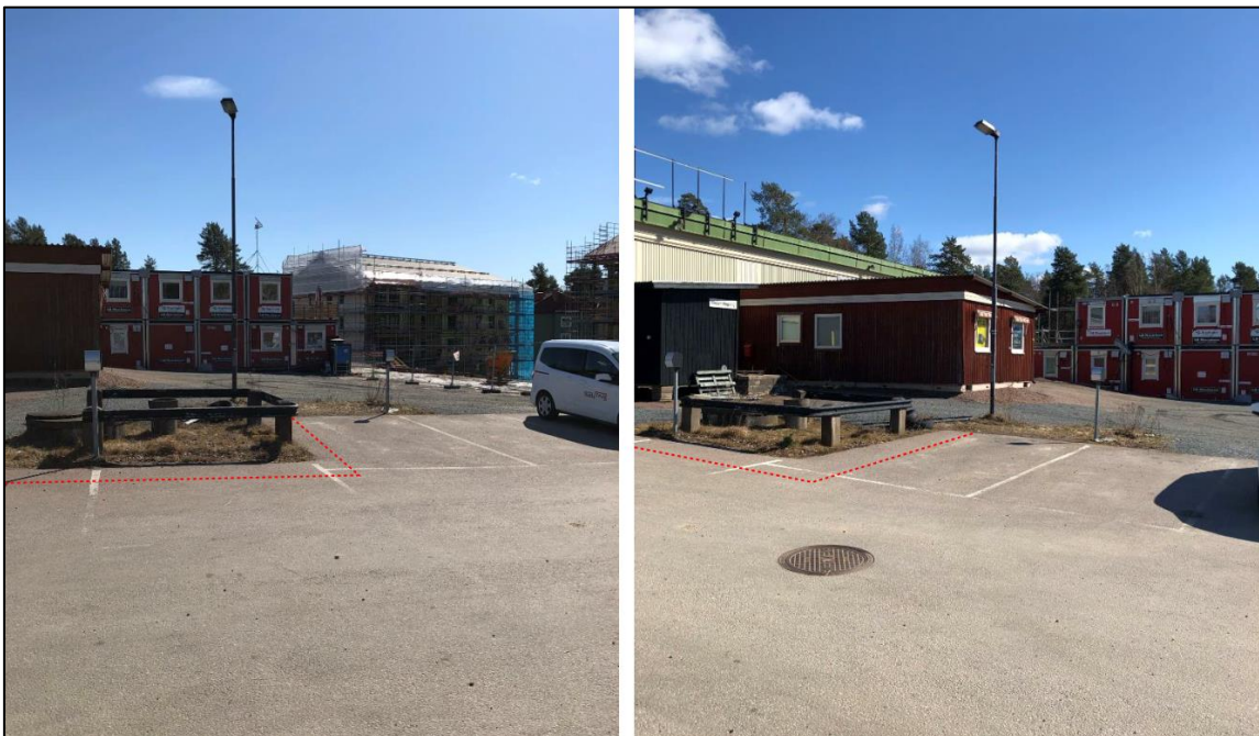
Figur 12. Spilloljecistern som återfinns i fastigheten Falun 8:54 södra delen, ungefärligt utbredningen av cistern har markerats med rött.
