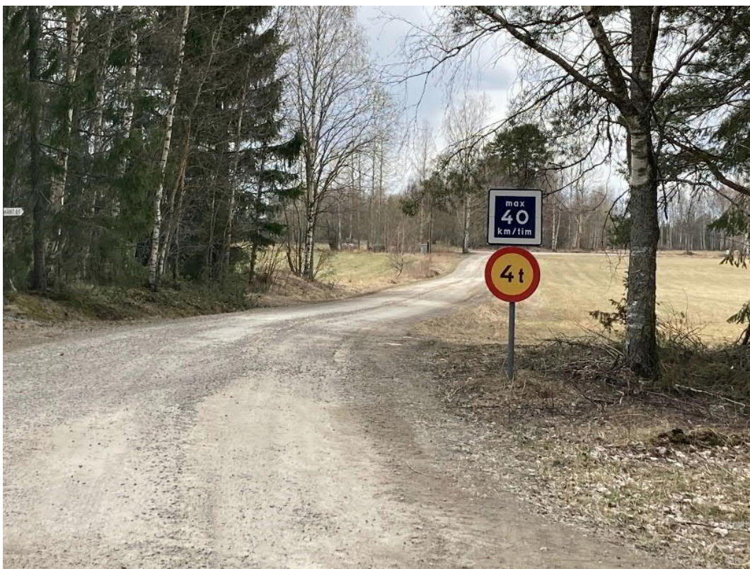
Figur 6. Vägen är reglerad med max 40 km/tim och under tjällossningsperioden en viktbegränsning. Vägmärket är uppsatt vid korsningspunkten cirka 350 meter från väg 800. Foto: WSP
