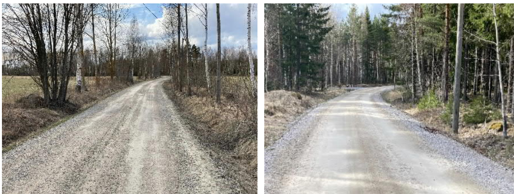
Figur 5. Grusvägen mot Näset varierar från 4,5 till 5,5 meters bredd och har tydliga diken. Foto: WSP
